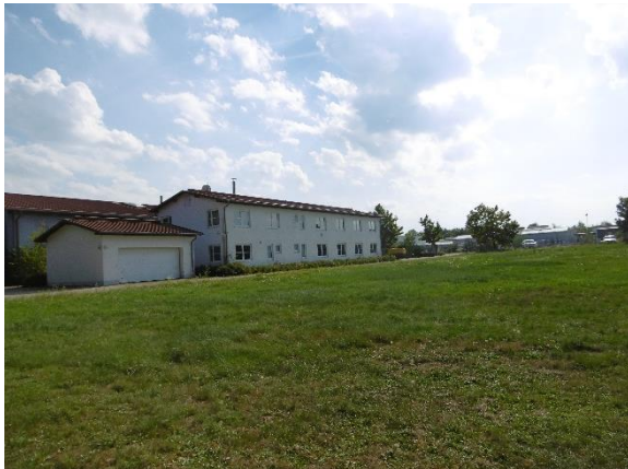
Abb. 3 Bestandsgebäude auf FINr. 531/3 mit geplanter Baufläche Blickrichtung Südwest, LaN, 22.08.2023
